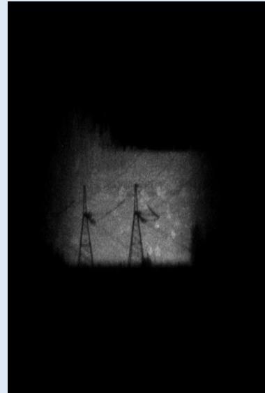
Опора ЛЭП на дальности 980 м
